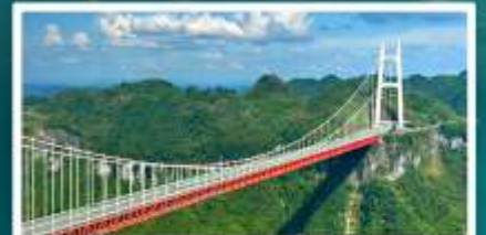
สะพานอ้ายจ้าย
